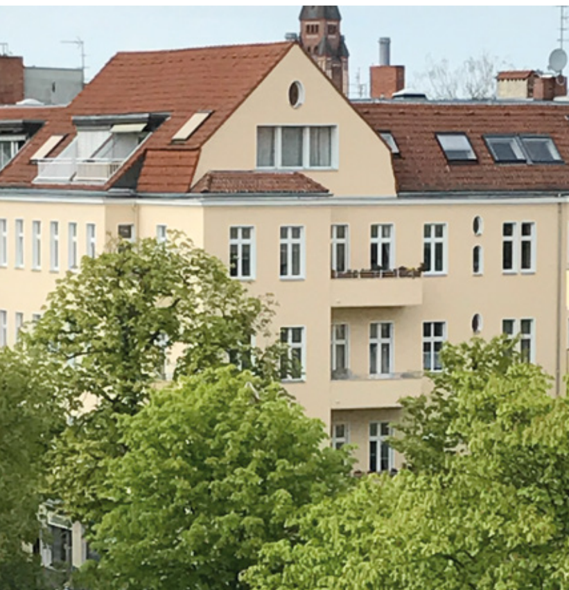
Unsere Wohnanlage Hackerstraße / Bornstraße in Steglitz nach der Sanierung.
